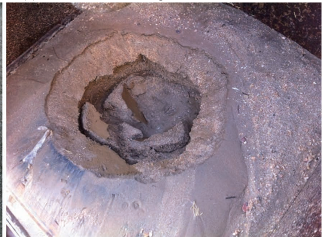
(d) Borehole With the Displacements of 60 L/min
